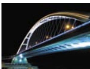
Heavy Metal: Stahlbrücke wiegt 8.000 Tonnen Heavy metal: An 8,000 ton steel bridge
